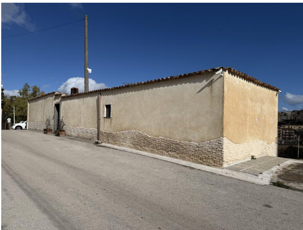
Foto n.1 Vista del fabbricato da via Umberto I.
