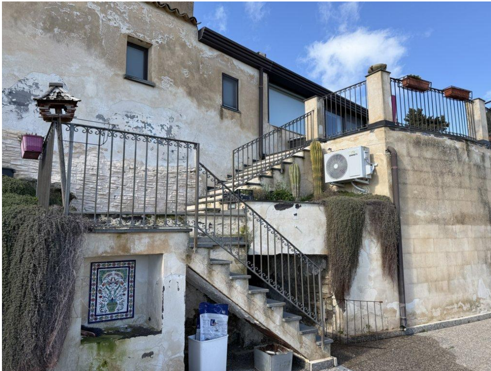
Foto n.17 Vista dele scale di collegamento esterne.
